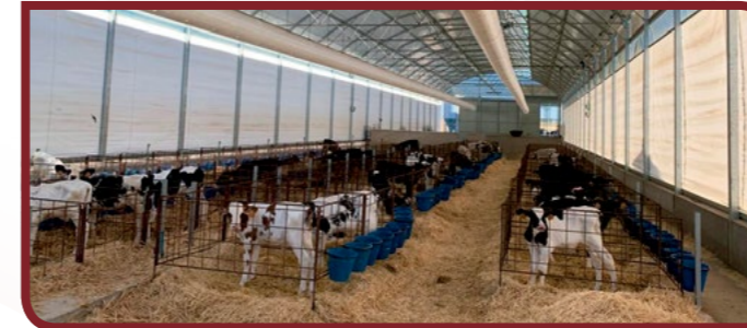
Tubos de renovación de aire.
