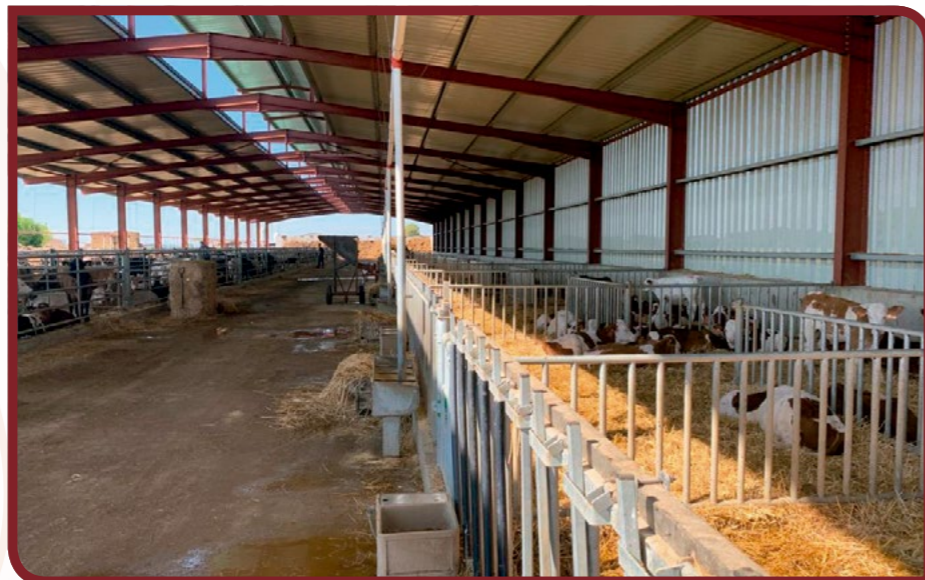
Nave con cortavientos, chapa perforada.
