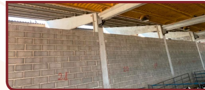
Chimeneas en el techo.
