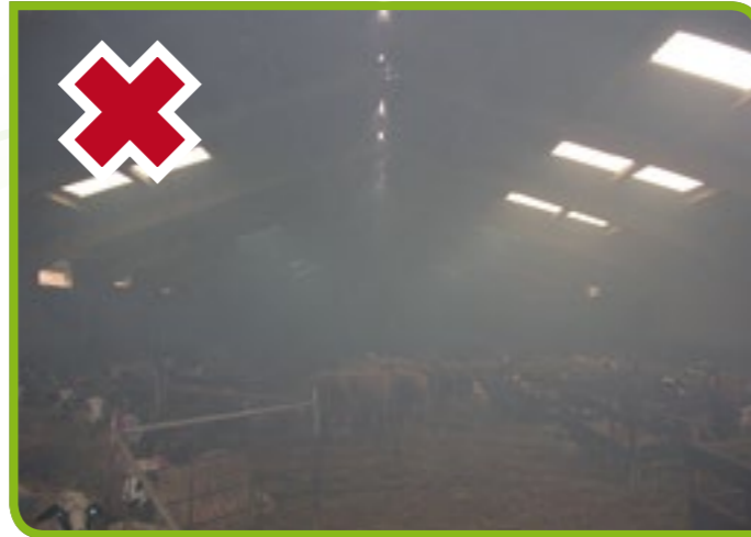
Nave con mala ventilación.
