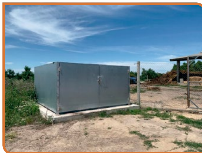
Depósito de cadáveres protegido.
