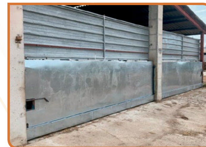
Protección lateral para el viento es muy importante la parte de abajo que toca el suelo para que no entre corriente.
