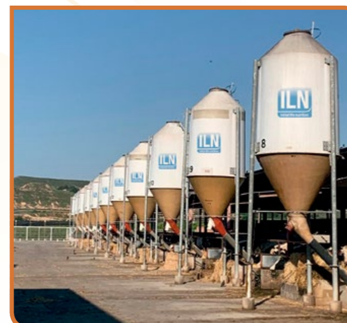
Silos de poliéster.
